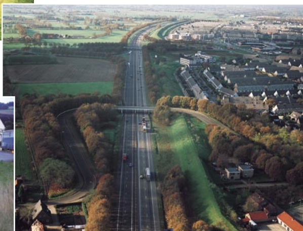
Een goede aansluiting op het omringende landschap en een dichte, opgaande begroeiing op het talud maken het voor sommige vleermuissoorten mogelijk veilig over of parallel aan het viaduct.
