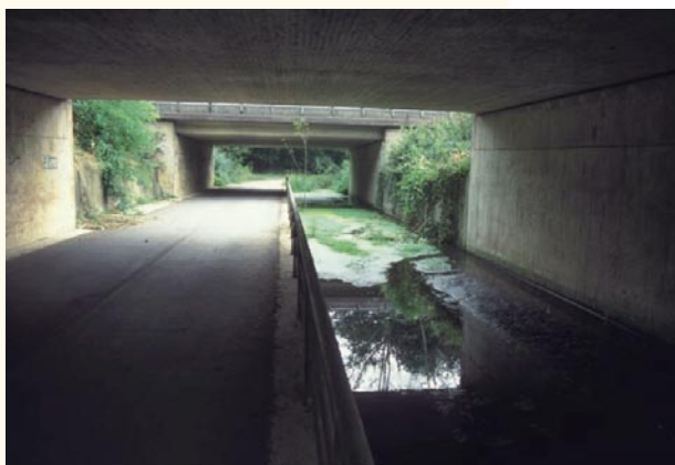
Een ruime onderdoorgang voor een secundaire weg kan door verschillende vleermuissoorten als passageplaats gebruikt worden.
