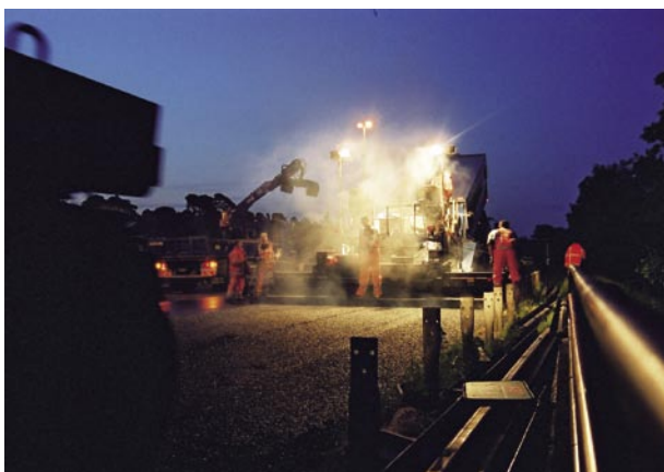
Werkzaamheden aan de weg kunnen vooral 's nachts verstoring voor vleermuizen opleveren.
